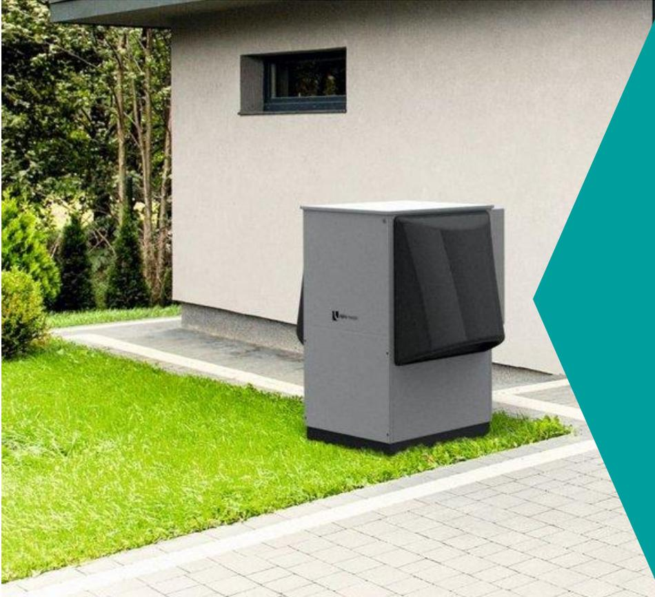
Aussenluft wird mit Ventilator angesaugt und lässt das Kältemittel verdampfen. Somit wird der Aussenluft Energie entzogen.
