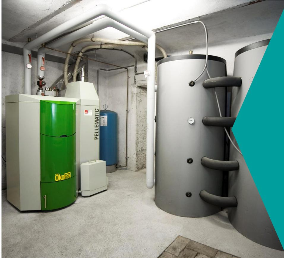
Pelletheizungen stellen hohe Temperaturen durch eine Verbrennung bereit. Wärmeabgabe erfolgt über den üblichen Heizkreis.
